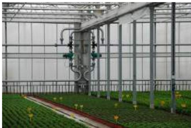
**Figura 14.** Instalación de calefacción por suelo radiante. Detalle de las válvulas de 3 vías y las bombas de recirculación
