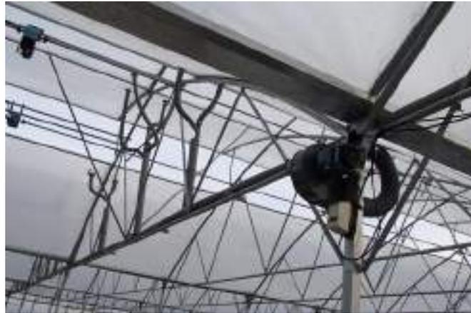
**Figura 13.** Detalle del sistema de inflado de la cubierta de plástico
