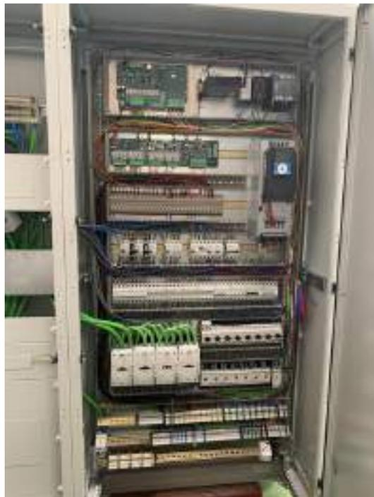
**Figura 26.** Cuadro de control, con los elementos de control en la parte superior, conectados a los elementos que controlan el funcionamiento de los dispositivos
