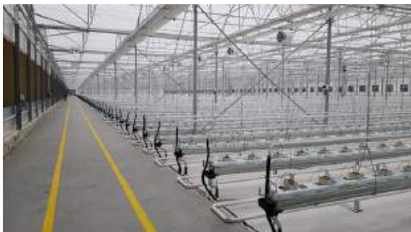
**Figura 16.** Instalación de calefacción por raíles y combinada con calefacción de cultivo de altura regulable
