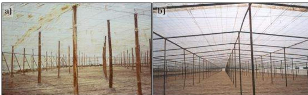
Figura 12. Imagen interior de invernaderos elementales sin ventilación cenital, con estructura plana y pilares de madera (a) y con estructura a dos aguas de tubos metálicos (b)
