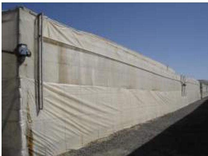
Figura 4. Detalle de ventilación lateral en invernadero “raspa y amagado”
