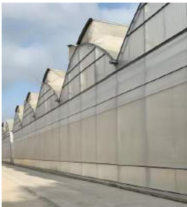
**Figura 2.** Invernadero multitunel con ventilación cenital doble y lateral, cubiertas con malla antiinsectos
