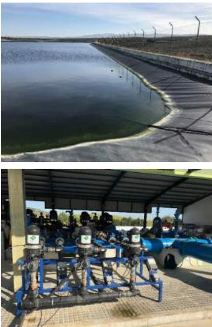
**Figura 18.** Balsa y estación de filtrado mediante anillas en planta piloto del proyecto de reutilización de aguas regeneradas en olivar REUTIVAR ([www.reutivar.eu](http://www.reutivar.eu))
