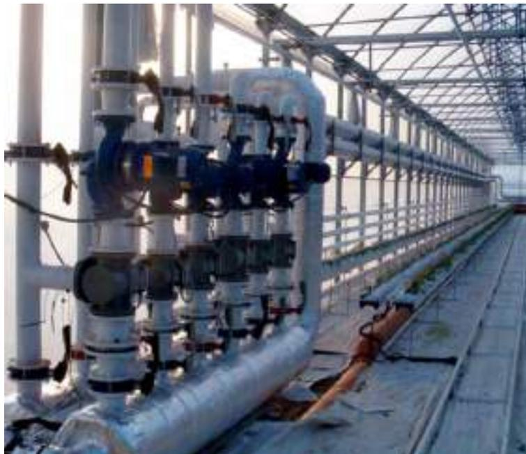
**Figura 18.** Colector para las redes de distribución y transporte a los distintos invernaderos, bombas de transporte y válvulas de tres vías
