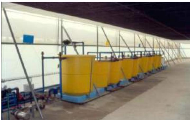
Figura 7. Tanques para fertilización en cabezal de riego por goteo
