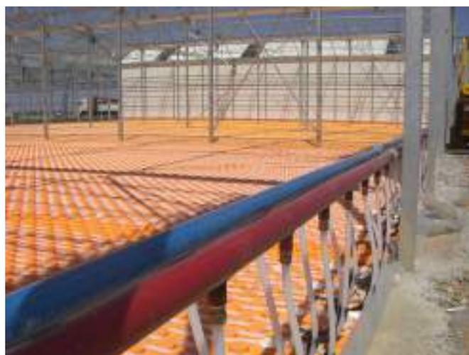
**Figura 15.** instalación de calefacción por suelo radiante. Detalle de la base aislante para instalar las tuberías de calefacción
